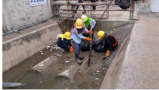
รูปที่ ค-13 (ข) การลอกตะกอนจากท่อระบายน้ำในโรงไฟฟ้า บริเวณโดยรอบพื้นที่ก่อสร้าง
