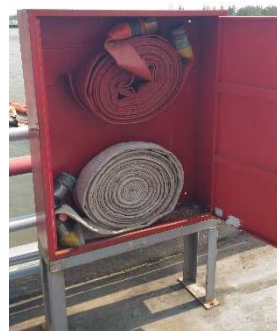
รูปที่ ค-91 หัวจ่ายน้ำดับเพลิงและสายยางขนาด 2.5 นิ้ว อยู่ภายในตู้ Hydrant บริเวณปลายท่า
