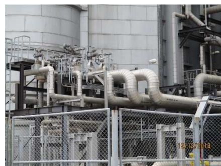
รูปที่ ค-73 ฉนวนป้องกันความร้อน (Insulation) และการปิดคลุม (Enclosures) แหล่งกำเนิดความร้อน
