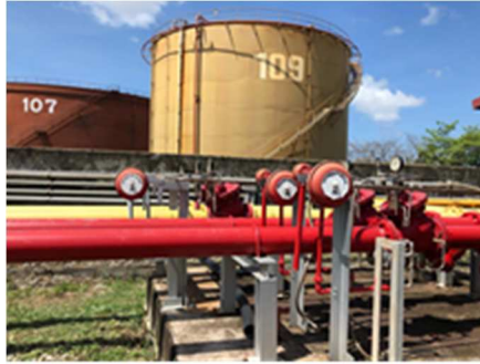
รูปที่ ค-98 ระบบกระจายน้ำดับเพลิงแบบอัตโนมัติ
