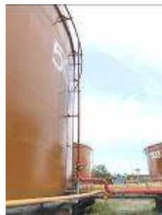
รูปที่ ค-96 ระบบโฟมอยู่บริเวณตรงข้ามกับอาคารทำการนายท่า โดยจะมีท่อโฟมส่งไปที่ถังเก็บน้ำมันทุกถัง
