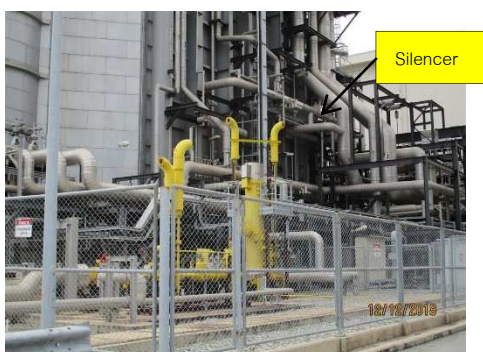
รูปที่ ค-55 ติดตั้งอุปกรณ์ลดเสียง (Silencer)
