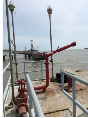
รูปที่ ค-89 เครื่องฉีดน้ำแบบตั้งอยู่กับที่
