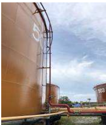
รูปที่ ค-97 ระบบ Water Spray ติดตั้งที่ถังเก็บน้ำมันทุกถัง
