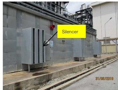
รูปที่ ค-54 ติดตั้งอุปกรณ์ลดเสียง (Silencer) บริเวณ Feed Water Pump
