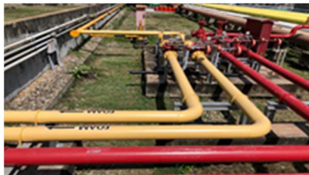
รูปที่ ค-99 ระบบหัวกระจายน้ำดับเพลิงแบบอัตโนมัติ ด้วยสารละลายโฟม
