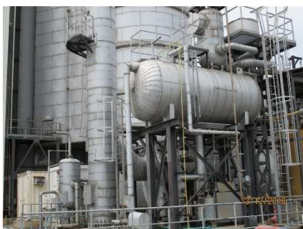
รูปที่ ค-73 ฉนวนป้องกันความร้อน (Insulation) และการปิดคลุม (Enclosures) แหล่งกำเนิดความร้อน
