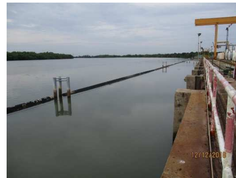
รูปที่ ค-66 ท่อนลอยดักขยะบริเวณหน้าอาคารสูบน้ำเข้าระบบหล่อเย็นของโรงไฟฟ้าฯ
