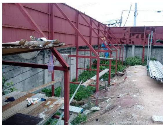
รูปที่ ค-8 กำแพงกันเสียง (ทำจากเหล็กหนา 1.27 มิลลิเมตร หรือวัสดุเทียบเท่า) ความสูงจากพื้นดิน 4 เมตร ในกรณีที่ใช้เสาเข็มตอก
