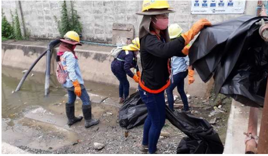
รูปที่ ค-13 (ข) การลอกตะกอนจากท่อระบายน้ำในโรงไฟฟ้า บริเวณโดยรอบพื้นที่ก่อสร้าง
