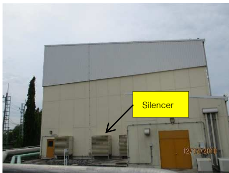
รูปที่ ค-53 ติดตั้งอุปกรณ์ลดเสียง (Silencer) บริเวณ อาคารคลุม Fuel Gas Compressor
