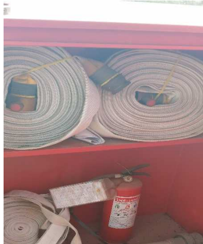
รูปที่ ค-92 ถังดับเพลิงแบบมือถือชนิด ABC Chemical อยู่ภายในตู้เก็บบริเวณปลายท่า
