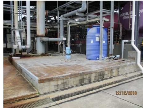
บ่อปรับสภาพให้เป็นกลาง (Neutralization Basin)
