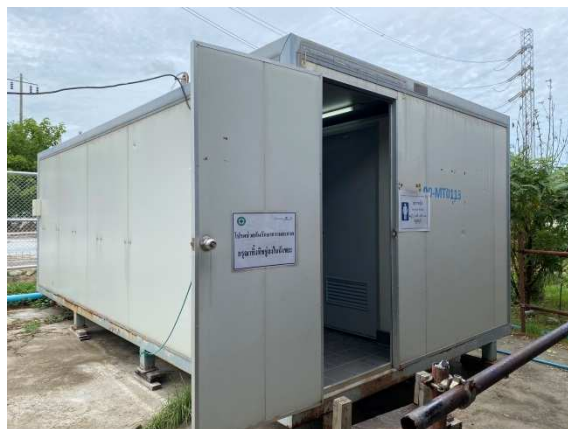
รูปที่ ค-12 ห้องน้ำ-ห้องสุขาสำหรับคนงาน ภาพถ่ายระบบบำบัดน้ำเสียสำเร็จรูป
