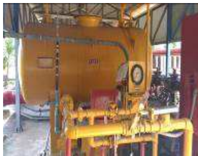
รูปที่ ค-96 ระบบโฟมอยู่บริเวณตรงข้ามกับอาคารทำการนายท่า โดยจะมีท่อโฟมส่งไปที่ถังเก็บน้ำมันทุกถัง
