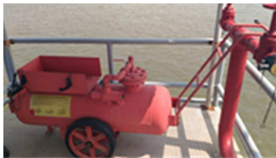
รูปที่ ค-93 เครื่องฉีดโฟมแบบเคลื่อนที่
