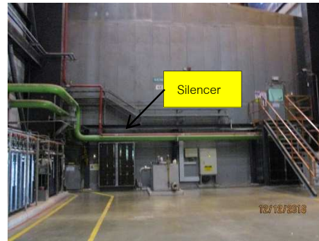
รูปที่ ค-52 ติดตั้งประตูกันเสียงบริเวณ เครื่องกังหันก๊าซโรงไฟฟ้าบางปะกง ชุดที่ 5
