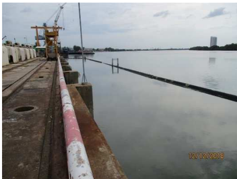
รูปที่ ค-66 ท่อนลอยดักขยะบริเวณหน้าอาคารสูบน้ำเข้าระบบหล่อเย็นของโรงไฟฟ้าฯ
