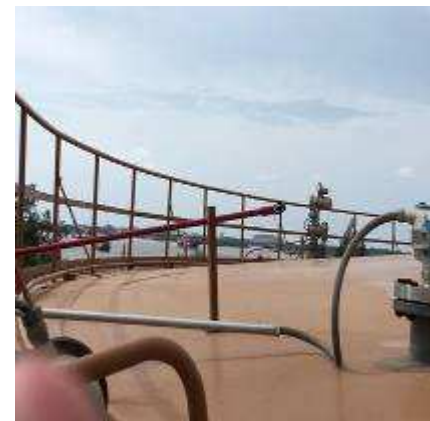
รูปที่ ค-97 ระบบ Water Spray ติดตั้งที่ถังเก็บน้ำมันทุกถัง
