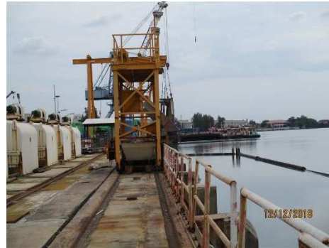
รูปที่ ค-65 เครื่องเก็บขยะบริเวณตะแกรงหน้าอาคารสูบน้ำเข้าระบบหล่อเย็นของโรงไฟฟ้าฯ
