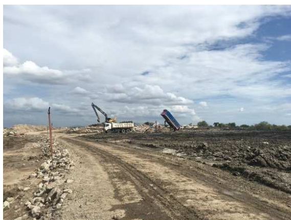
รูปที่ ค-17 การนำดินที่ขุดไปปรับถม บริเวณพื้นที่ของโรงไฟฟ้า
