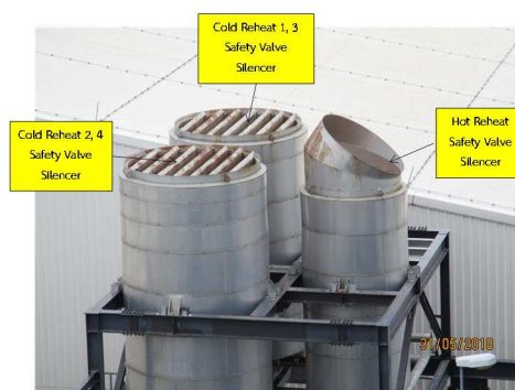
รูปที่ ค-50 ติดตั้งอุปกรณ์ลดเสียง (Silencer) บริเวณกังหันไอน้ำโรงไฟฟ้าบางปะกง ชุดที่ 5
