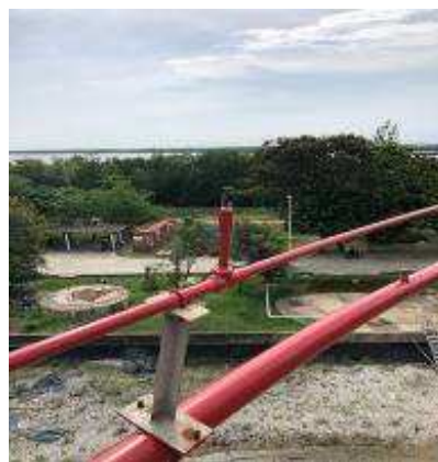
รูปที่ ค-97 ระบบ Water Spray ติดตั้งที่ถังเก็บน้ำมันทุกถัง
