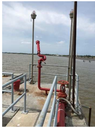
รูปที่ ค-89 เครื่องฉีดน้ำแบบตั้งอยู่กับที่
