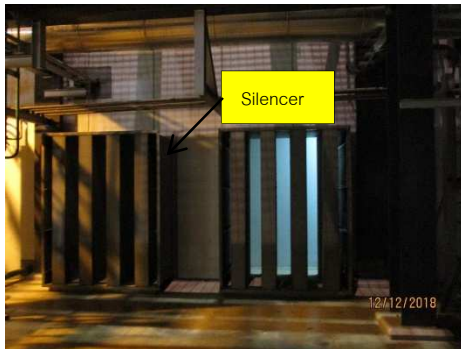
รูปที่ ค-51 ติดตั้งอุปกรณ์ลดเสียง (Silencer) บริเวณ Steam Turbine Enclosure โรงไฟฟ้าบางปะกง ชุดที่ 5
