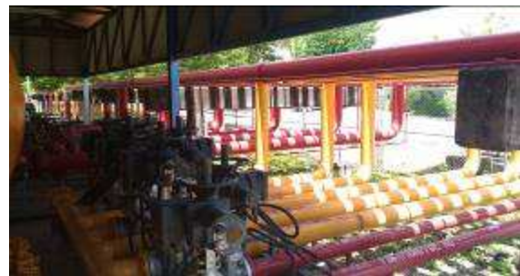
รูปที่ ค-96 ระบบโฟมอยู่บริเวณตรงข้ามกับอาคารทำการนายท่า โดยจะมีท่อโฟมส่งไปที่ถังเก็บน้ำมันทุกถัง
