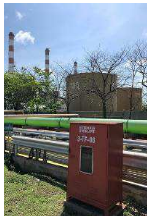
รูปที่ ค-101 หัวจ่ายน้ำดับเพลิง Hydrant ติดตั้งบริเวณรอบนอกของถังเก็บน้ำมัน
