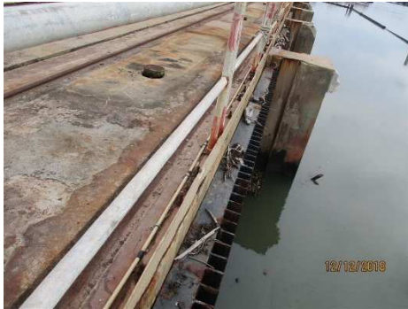
รูปที่ ค-65 เครื่องเก็บขยะบริเวณตะแกรงหน้าอาคารสูบน้ำเข้าระบบหล่อเย็นของโรงไฟฟ้าฯ
