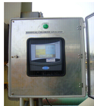
รูปที่ ค-64 การตรวจวัดอุณหภูมิและค่าคลอรีนอัตโนมัติของโรงไฟฟ้าบางปะกง
