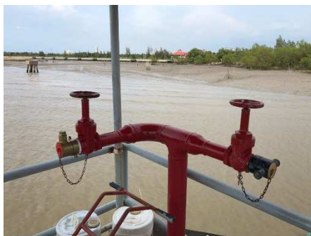
รูปที่ ค-91 หัวจ่ายน้ำดับเพลิงและสายยางขนาด 2.5 นิ้ว อยู่ภายในตู้ Hydrant บริเวณปลายท่า
