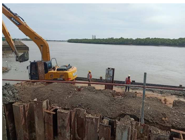
รูปที่ ค-16 ระบบป้องกันดินพัง (Sheet Pile) ในการก่อสร้างระบบบ่อบำบัดน้ำสำหรับเติมหอหล่อเย็น ปัจจุบันสิ้นสุดระยะการก่อสร้างที่ต้องใช้ระบบป้องกันดินพัง เนื่องจากบ่อบำบัดน้ำสำหรับเติมหอหล่อเย็นก่อสร้างแล้วเสร็จ
