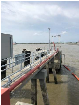
รูปที่ ค-90 ท่อน้ำดับเพลิงขนาดเส้นผ่าศูนย์กลาง 200 มิลลิเมตร
