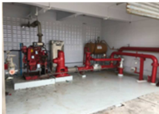
รูปที่ ค-94 เครื่องสูบน้ำดับเพลิง
