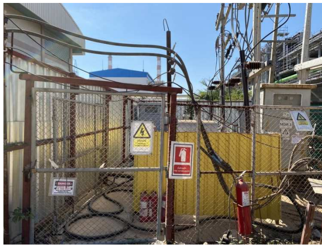
ป้ายเตือนและรั้วตาข่ายกัน บริเวณหม้อแปลงไฟฟ้าแรงสูงชั่วคราว
