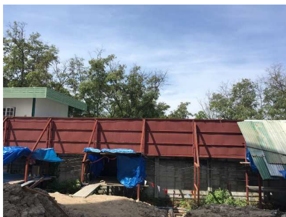
รูปที่ ค-8 กำแพงกันเสียง (ทำจากเหล็กหนา 1.27 มิลลิเมตร หรือวัสดุเทียบเท่า) ความสูงจากพื้นดิน 4 เมตร ในกรณีที่ใช้เสาเข็มตอก
