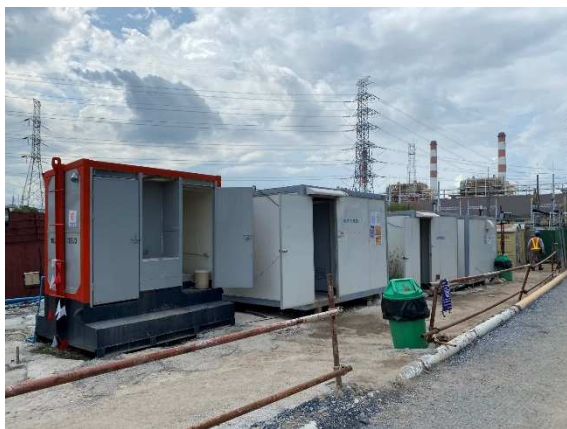
รูปที่ ค-12 ห้องน้ำ-ห้องสุขาสำหรับคนงาน ภาพถ่ายระบบบำบัดน้ำเสียสำเร็จรูป
