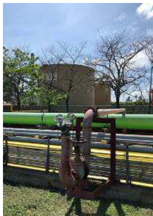
รูปที่ ค-101 หัวจ่ายน้ำดับเพลิง Hydrant ติดตั้งบริเวณรอบนอกของถังเก็บน้ำมัน
