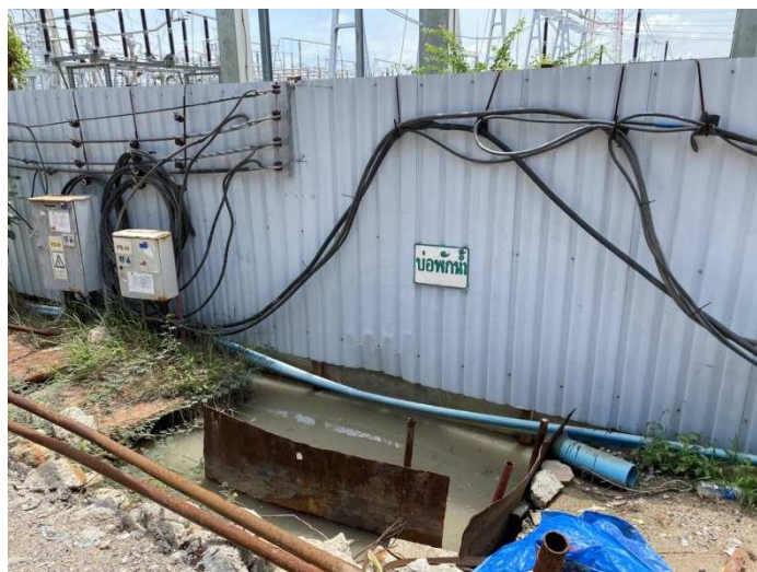
รูปที่ ค-11 บ่อพักน้ำชั่วคราว เพื่อตกตะกอนน้ำทิ้งจากกิจกรรมการก่อสร้าง
